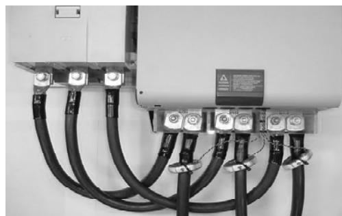
Figura 9.14 - TCs para adquisición de corriente externa
